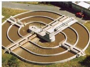
Orbal™ Oxidation Ditch
